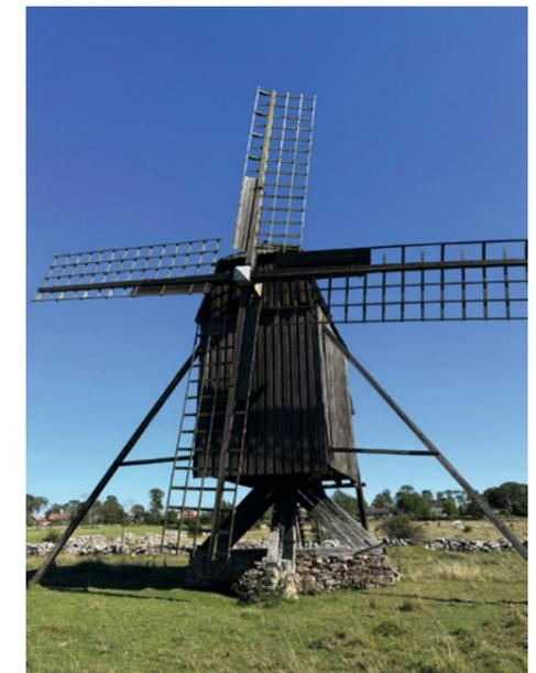
Abbildung 5.5: Windmühle, die die Bewässerung von Höfen und Feldern / Vieh sicherstellt. Sie konnte manuell in den Wind gedreht werden, Öland. © Streichert
